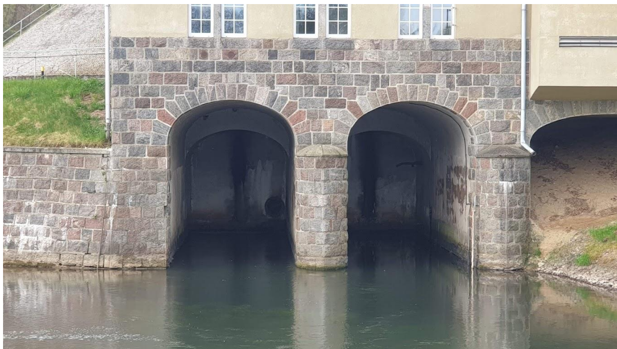
Elektrownia wodna na rzece Raduni w Rutkach
