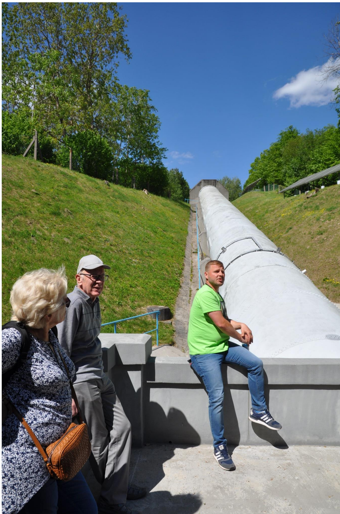
Koniec wielokilometrowego skrótu napływu wody. Średnica rury 3,6 m
